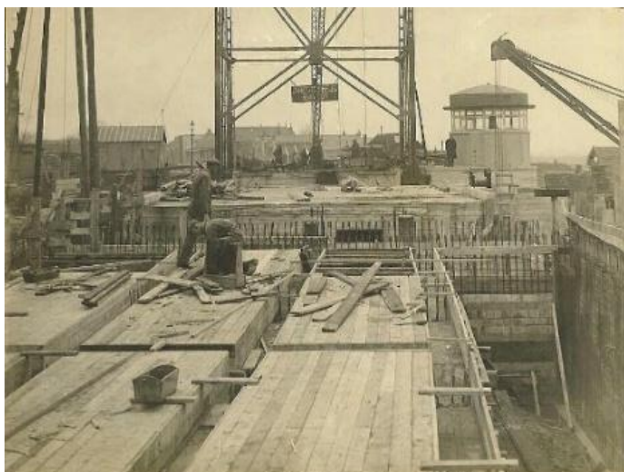
Arie {staand} en Gerrit Neven bouwen in 1936 aan de hefbrug
